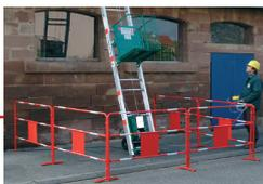
Pour la sécurité du personnel de chantier, la zone dangereuse doit impérativement être délimitée par un dispositif matériel lors de l'utilisation de nos monte-matériaux. Pour des barrières, nous consulter.
